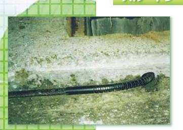
スルードレーンは、舗装体に浸透した雨水を速やかに排出し、滞留した雨水により基層や床版が劣化することを防止する耐熱性の樹脂製導水管です。
