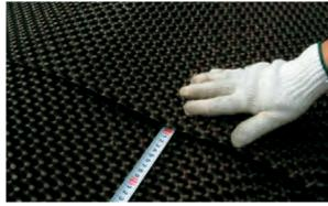
■エンボス凸部がざらついている方を表にして敷設してください。 重ね合わせ部は瓦積み状になるように、エンボス同士を重ね合わ せ敷設します。(標準重ね代は10cmです)
