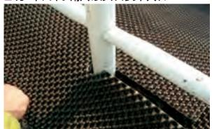
■ガードパイプ用穴開け、スリット入れをカッター・鋏等で行います。 ホールソーを使用するとさらに簡単です。ガードパイプ周辺は、 コーキング材処理を行い、スリット部には上から「ナクサ」を被せ、 周辺にアンカーピンを打ちます(パッチあて)。
