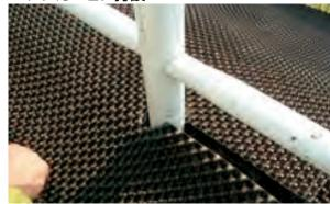
■アンカーピンにナクサワッシャを取り付けてから、アンカーピンを 打設します。法尻部のアンカーピンは風によるめくれを防止する ため、400mm長さを使用します。(標準ピッチ50cm)
